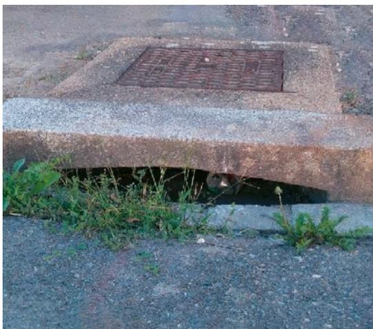
Gueule de four : les macro-déchets pénètrent directement dans les réseaux pluviaux
